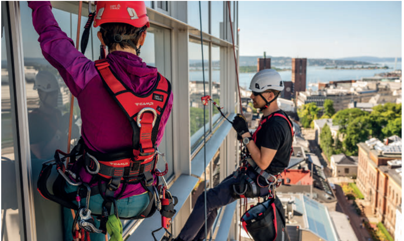
Philippa Betts and Torbjørn Solheim take in the view during rope access maintenance operations on a building facade. Las cuerdas dan a Philippa Betts y Torbjørn Solheim acceso a la fachada de un edificio para realizar operaciones de mantenimiento. Universitetsgata 2, Oslo, Norway (courtesy of Varri AS, ph.Kyrre Buxrud).
