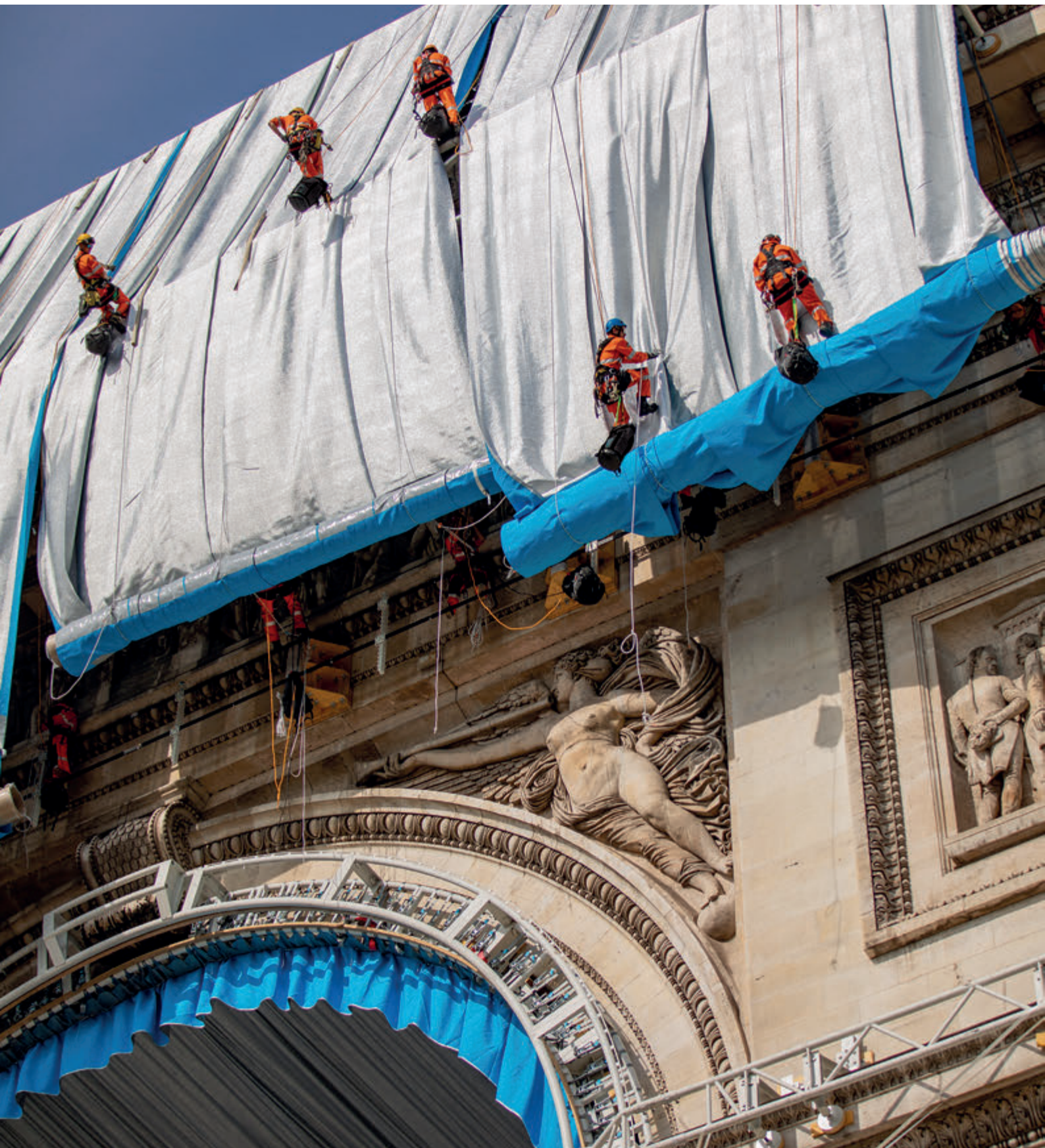
Jade professionals at work on Christo's latest work: the wrapped Arc de Triomphe. Profesionales de Jade trabajando en la última obra de Christo: el Arco del Triunfo empaquetado. Paris, France (courtesy of Jade, ph. Daniel Lengart).
