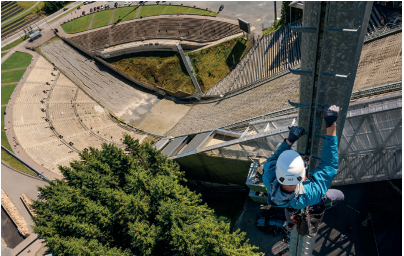
Torbjørn Solheim doing maintenance operations at the famous Holmenkollen ski-jump structure. Torbjørn Solheim realiza tareas de mantenimiento en la famosa estructura para el salto de esquí de Holmenkollen. Oslo, Norway (courtesy of Varri AS, ph.Kyrre Buxrud).
